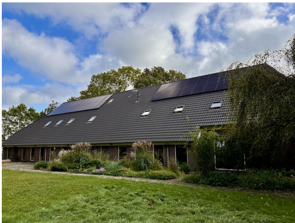
De westkant van het hoofgebouw met zonnepanelen
